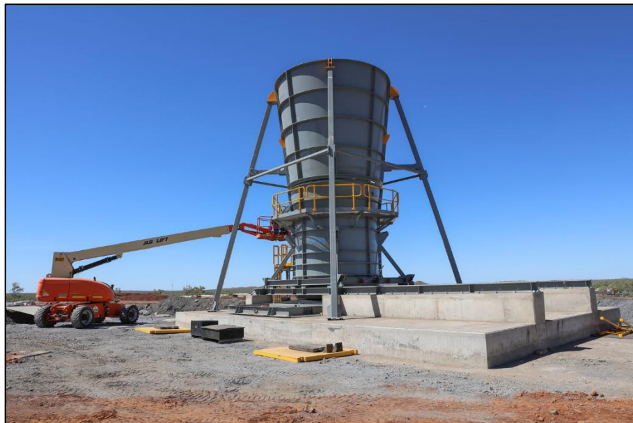
Figura 6 - Ventilador axial tipo vertical
