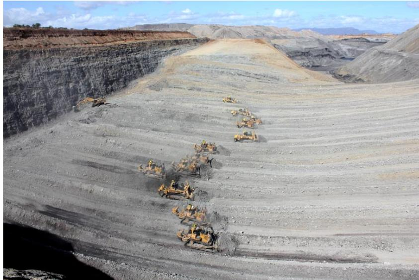
FIGURA 4: Utilização de tratores de esteira para terraplanagem
